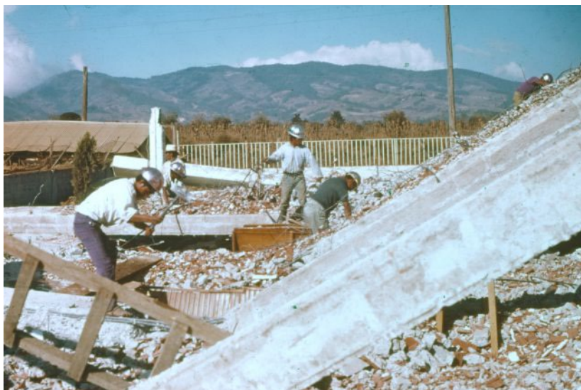
Demolición de la iglesia en Patzicía, Guatemala
