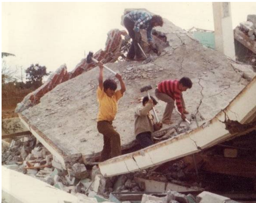
Miembros ayudan a romper el techo de la iglesia de Patzicía
