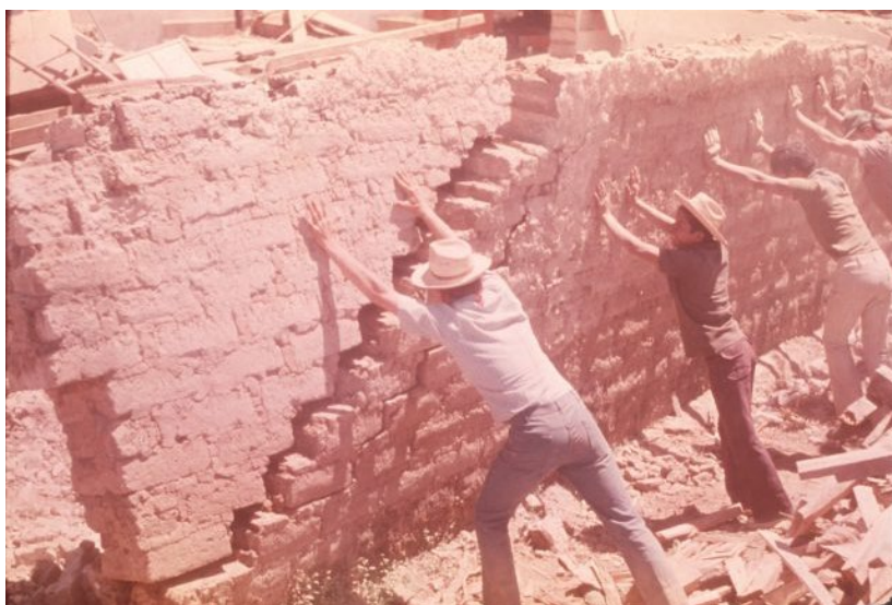
Cómo derribar una pared de adobe: Paso 2. El élder Richman y otros la empujan.
