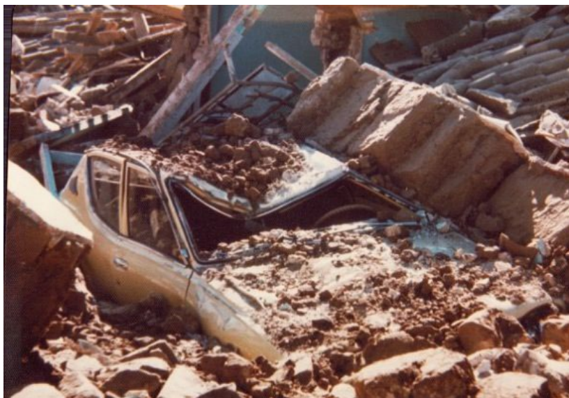
Carro aplastado por el peso de las paredes de adobe.
