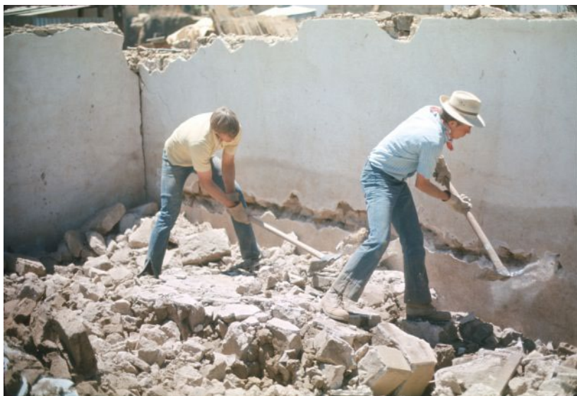
Cómo derribar una pared de adobe: Paso 1. El élder Larson y el élder Richman quitando el yeso de una pared.
