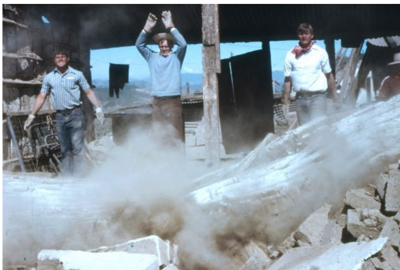
El élder Warnock (a la izquierda) y el élder Larson (a la derecha) derriban las paredes dañados después del terremoto en Guatemala de 1976.
