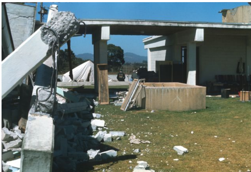
Parte trasera de la iglesia y pasillo cubierto hacia los baños.
