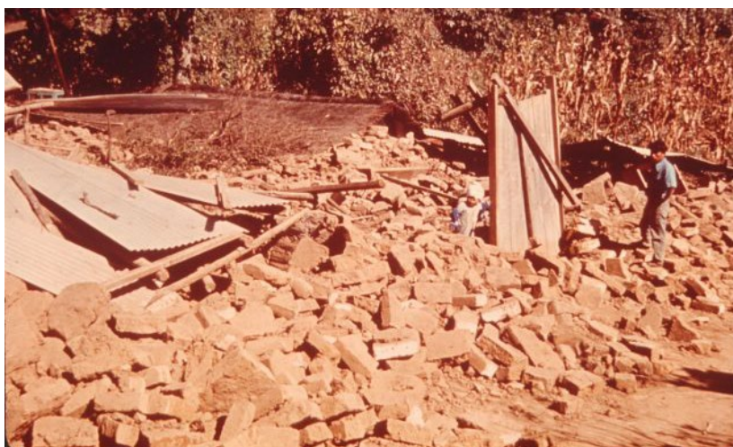
Restos de la casa de Pablo Choc tras el terremoto. Solo queda en pie la puerta en medio del muro exterior derrumbado.
