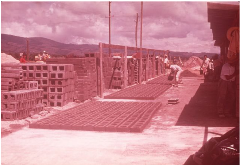
Campamento de construcción fabricando bloques de hormigón
