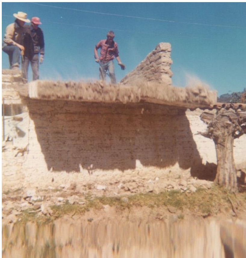
Derribando una pared
