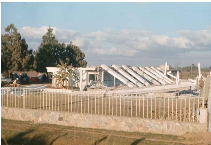
Demolición de la iglesia en Patzicía, Guatemala
