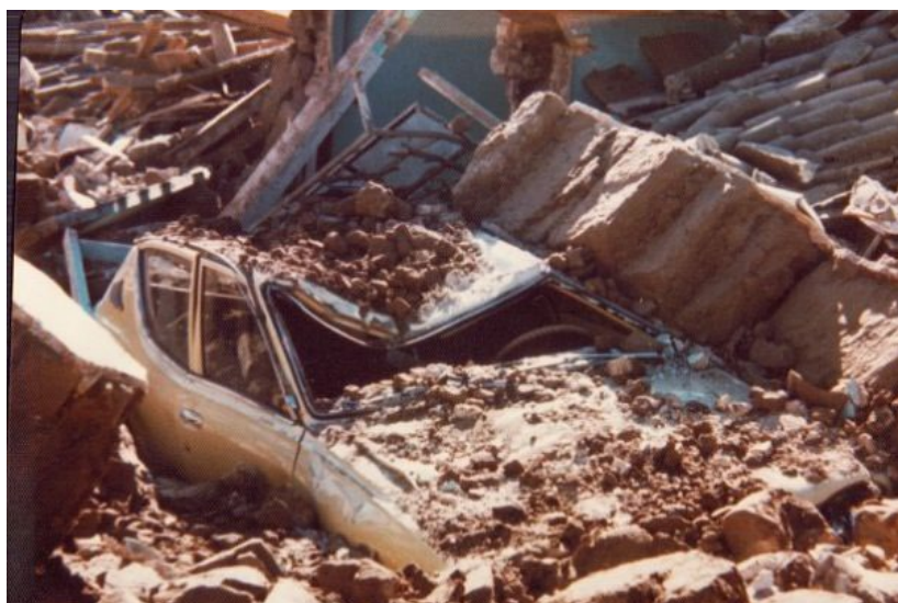
Carro aplastado por el peso de los muros de adobe.
