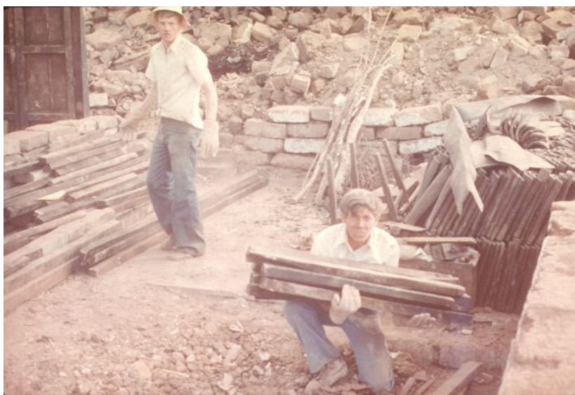
Los élderes Bernhardt y Richman apilan maderas después de desmontar un techo en Sumpango
