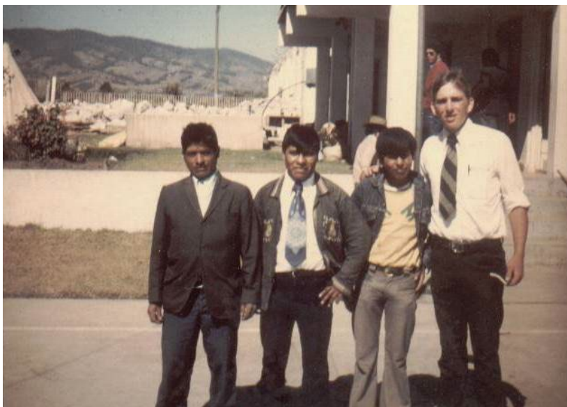
El presidente de la rama Pablo Choc, sus hijos, el élder Daniel Choc y Agustín Choc, y el élder David Frischknecht detrás de la iglesia caída en Patzicía después de que se retiraron la mayor parte de los escombros.
