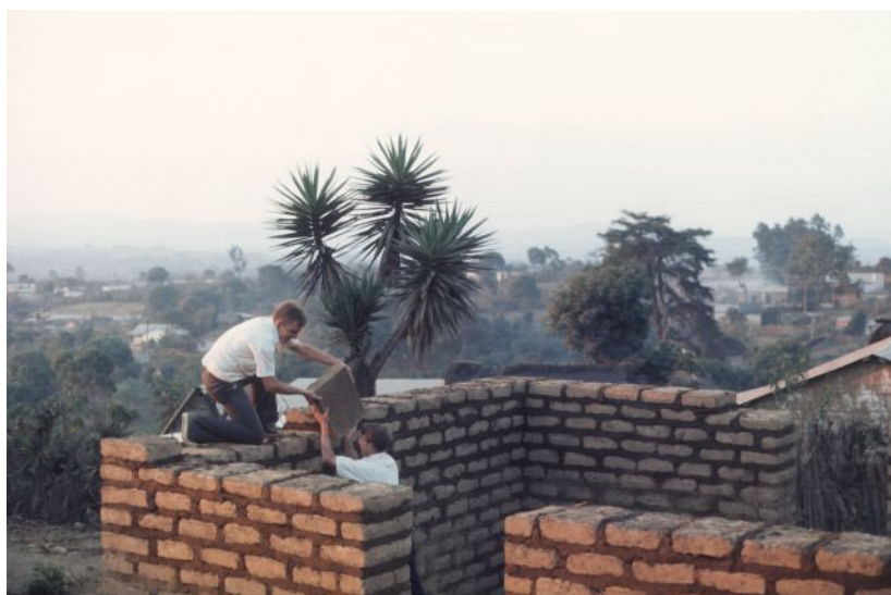
Construyendo una casa de adobe, el élder Frischknecht y el élder Richman
