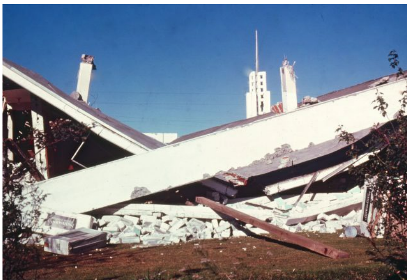
Parte trasera de la iglesia en Patzicía, Guatemala después del terremoto de 1976 (Foto cortesía de Michael Morris)
