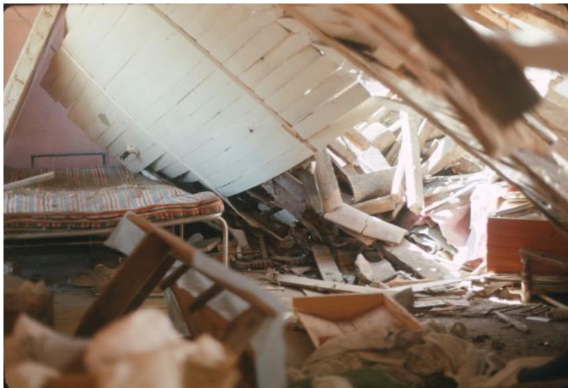
Dentro de nuestro apartamento en Comalapa después del terremoto. La cama de Eber está a la izquierda. Mi cama está a la derecha. (La manta roja a los pies de mi cama apenas se ve. El techo se derrumbó después de que salimos de la habitación).
