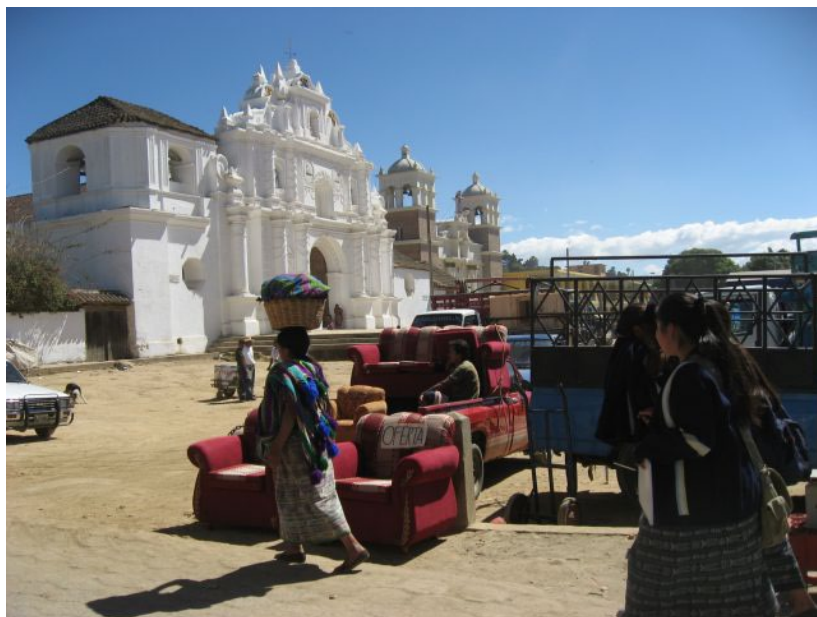
En 2009, se muestra la fachada de la antigua iglesia católica de Comalapa reconstruida y una nueva iglesia a su lado.
